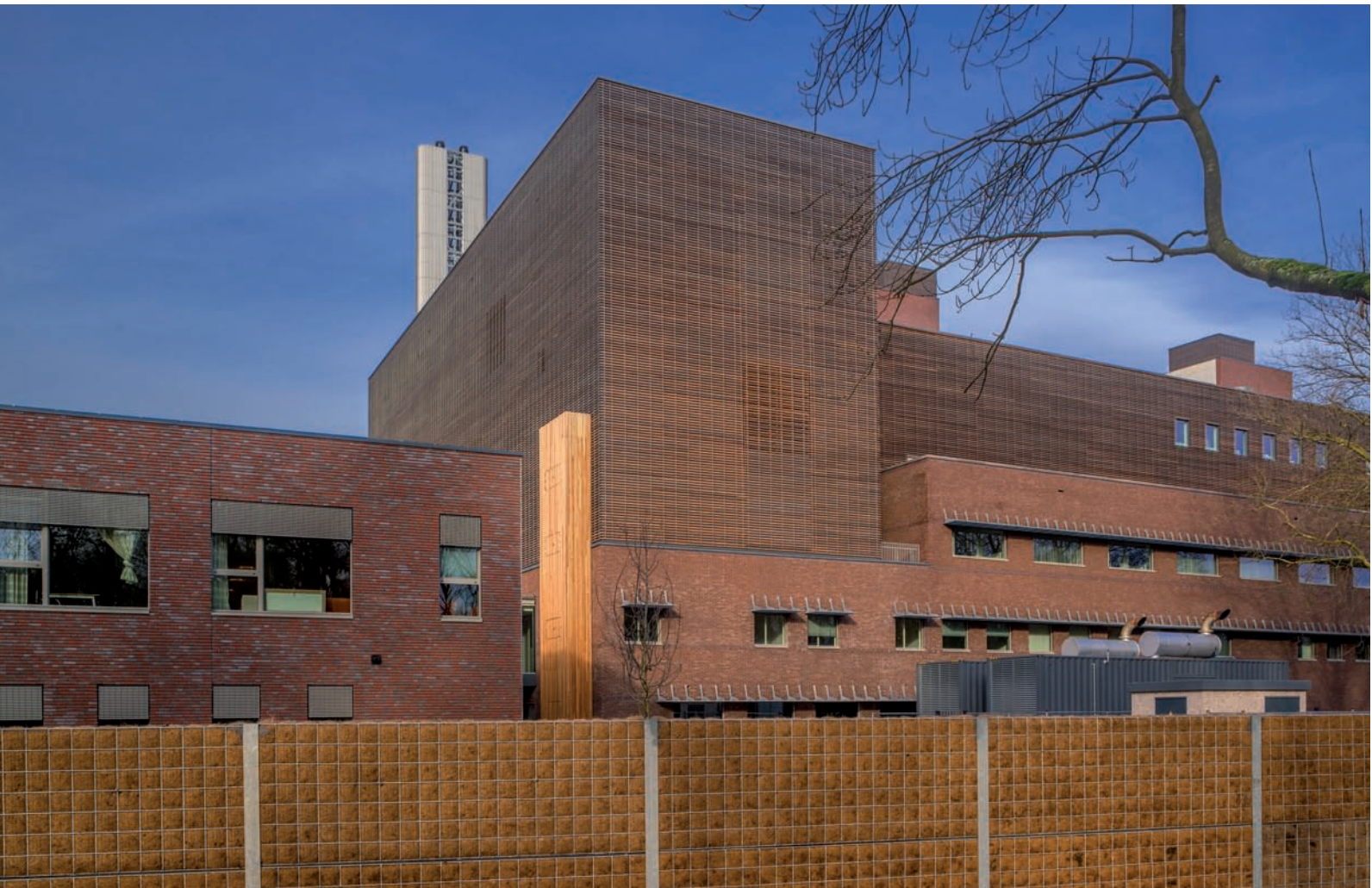
De open gevelbekleding van western red cedar op het techniekgebouw maakt het tot het pronkstuk van het complex.
