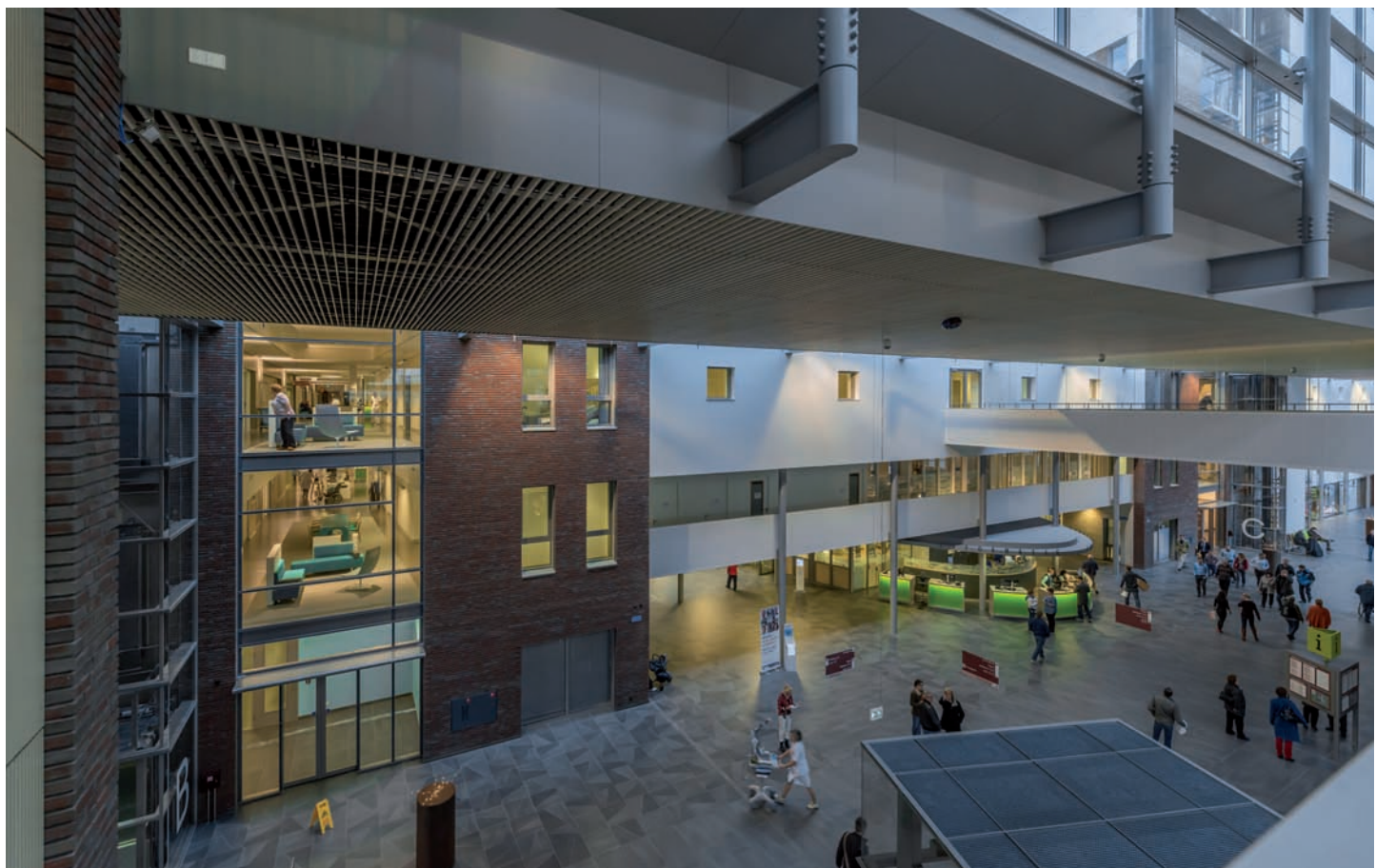
De Laan met rechts centrale balie en links inkijkje in schegvormige gemeenschapsruimte verpleegafdeling. Lattenplafond van gewitewasht abachi.
